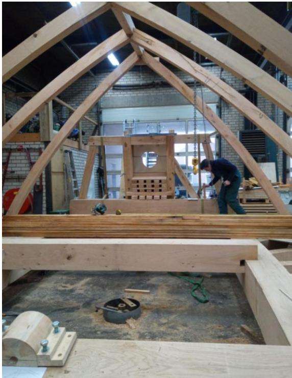
Ansicht der Kappe von hinten: Vorn links befindet sich die Halterung für das hintere Lager der Rutenwelle. In der Mitte ist der Königsbalken zu erkennen.
