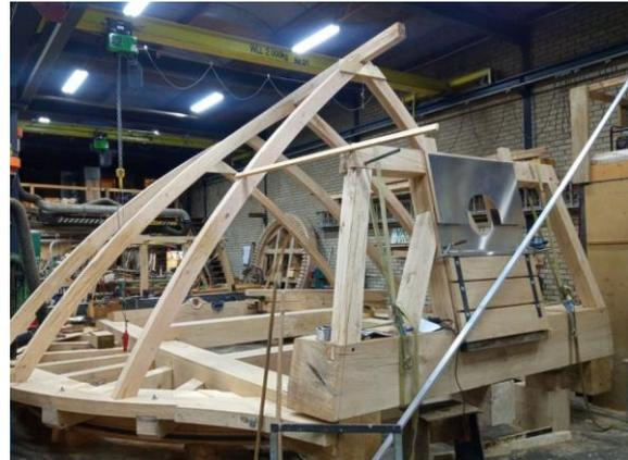
*Die Kappe von der Vorderseite: Vier Gebindebalken auf jeder Seite formen das spätere Dach. Im Vordergrund ist der große Wellbalken zu erkennen, der später das vordere Lager für die Rutenwelle (= Flügelwelle) trägt.*
