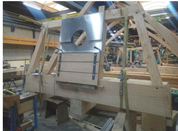
*Die Öffnung für die Rutenwelle und den Wellkopf trägt zum Schutz gegen die Witterung eine Blechabdeckung.*
