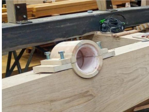
Die hintere Lagerhalterung. Dahinter ist der kleine Schwertbalken zu sehen. Die beiden Schwertbalken wurden aus Metall angefertigt, denn sie werden beim Drehen der Kappe stark beansprucht.
